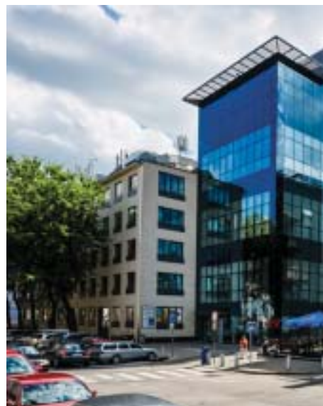
Sídlo spoločnosti Roche Slovensko s.r.o.
